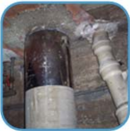
Réparation de conduits de vides-ordures
