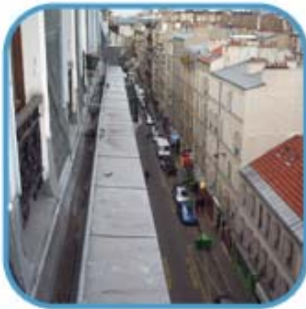
Nettoyage des chéneaux
