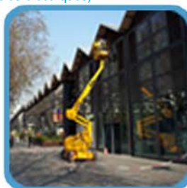
Travail sur nacelle (câbles électriques)
