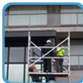
Travail sur échafaudage (câbles électriques)
