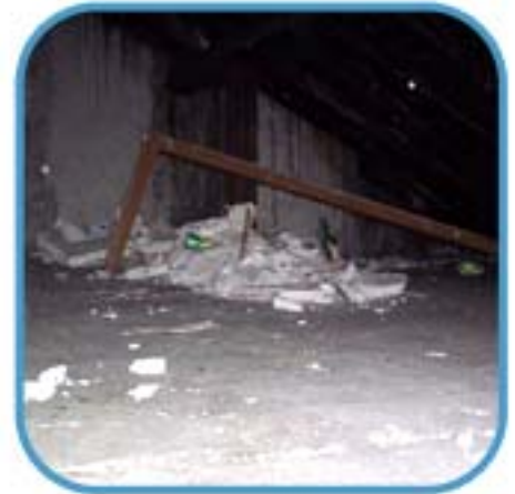
Enlèvement de gravats
