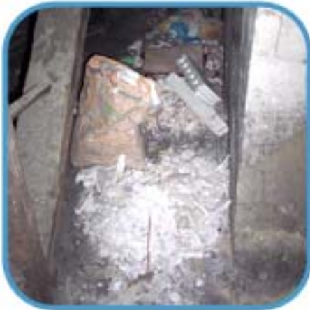
Enlèvement de gravats
